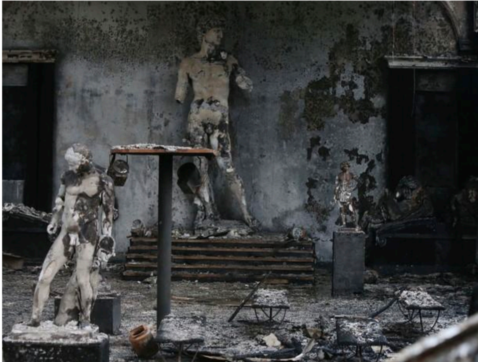
Fig. 4 – Incêndio no Liceu de Artes e Ofício, em 2014. Foto de Marcos Bezerra. Fonte: https://g1.globo.com/sao-paulo/noticia/2014/02/incendio-destroi-acervo-do-liceu-de-artes-e-oficios-em-sp.html . Acesso em 15 jun. 2024.
